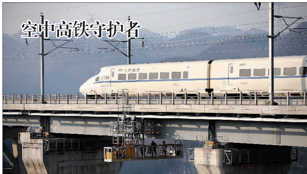
成贵高铁西溪河大桥横跨贵州省毕节市乌蒙山的西溪河大峡谷，这里山高谷深、地势险要，桥面至河面高差达250多米，冬季常有凝冻现象，寒风更是凛冽刺骨。为保障每天数十趟高铁动车组的安全通过，贵阳高铁工务段职工们克服了海拔高、气候恶劣等困难，在250多米的高空中对大桥进行体检，全力确保行车安全。图为工人在西溪河大桥下进行检查作业。 ■新华社传真照片
