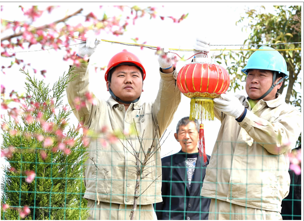
日前,县供电公司灰墩供电所员工对灰墩农家休闲采摘园内的用电线路进行安全检查,及时消除用电隐患,保证采摘园用电可靠。(丰其生 摄)
