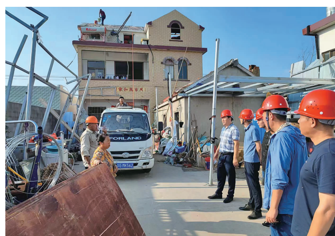
连日来,灌云县直镇县镇两级人大代表顶烈日冒酷暑坚持在受龙卷风影响的唐桥村,积极主动协调人力、物力,帮助受灾村民修缮房屋,维修电力、通讯杆线,清理村庄道路和倒伏树木。目前,唐桥村206户受灾村民的生产和生活已恢复正常。 (邹毅 刘锐)
