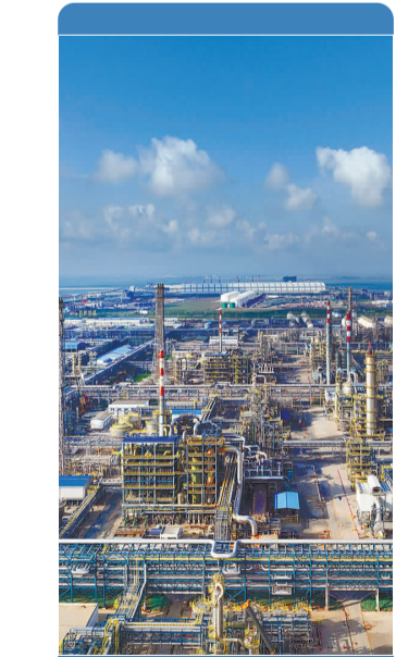
近年来,连云港石化产业基地建设步入快车道,这里已形成独具特色的盛虹石化、卫星化学、中化国际三大石化产业集群,30多个重大产业项目筑成“钢铁森林”。图 为8月1日拍摄的连云港石化产业基地建设场景。 记者 王健民 通讯员 王鑫 摄影报道
