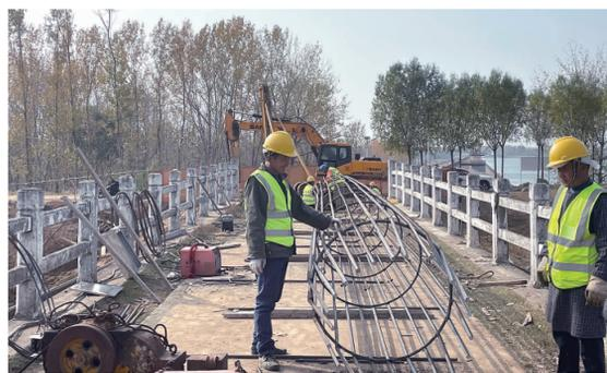
近日,由东海县交通运输局下属企业东海县路桥公司承建的后昌西桥改建工程项目已全面开工。该项目位于东海县双店镇后昌村,老桥为一座单跨35米双曲拱桥,桥梁全宽5.5米,因年久失修,目前桥梁损坏严重,为方便居民出行,决定对该桥进行拆除重建,桥梁改建为3-20预应力混凝土空心板桥,桥面总宽9米,净宽8米。(谷源 周作庆)
