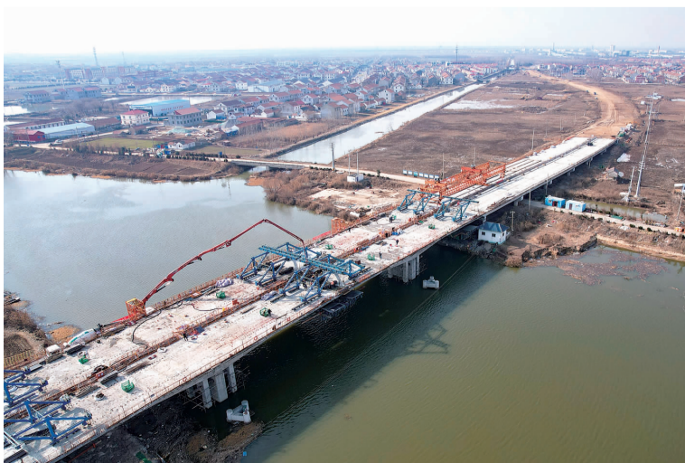
日前,402省道赣榆南环段路桥涵工程沱北运河大桥主桥中跨顺利合龙,为402省道赣榆南环段工程项目全线通车奠定了坚实基础。 记者 张泽瑞 通讯员 吴从飞 司徒 摄影报道
