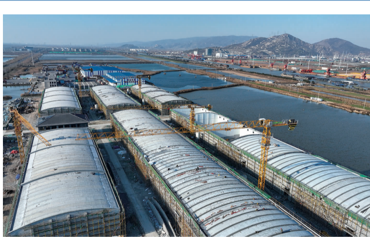
日前,丰禾10万吨粮食仓储库项目建设的场景。该项目位于连云区板桥工业园,是全市重点建设项目之一。该项目总投资2.63亿元,总建筑面积23785.3平方米,预计将于今年6月份投产运营。 记者 王健民 摄
