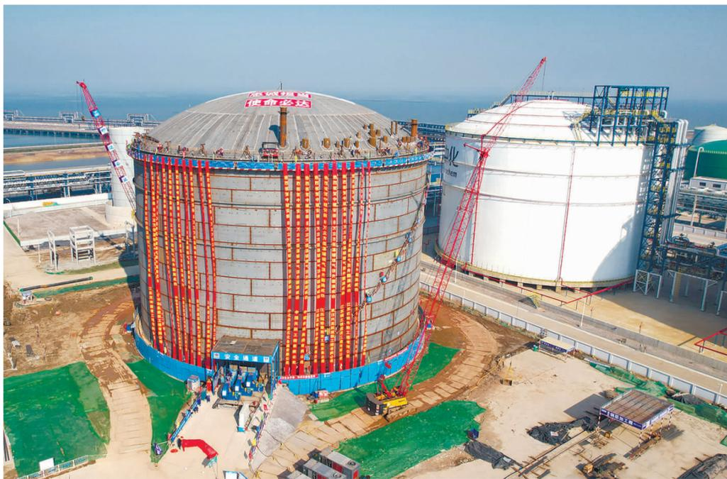
昨日,由中建安装上海公司承建的中化连云港低温储罐二期项目8万立方米低温储罐顶升成功,标志着外罐主体结构全面完工,即将进入罐内施工阶段。在建设现场,2台风机将直径60多米、重量600多吨的储罐穹顶提升37.83米,顺利与承压环闭合衔接。该装置是中化连云港产业园的重要基础设施,包含最大罐容为8万立方米低温丙烷/丁烷储罐和12万立方米低温丙烷混凝土储罐。建成后,将助力打造徐圩世界一流石化基地,为连云港高质量发展提供更为坚实的战略支撑。
