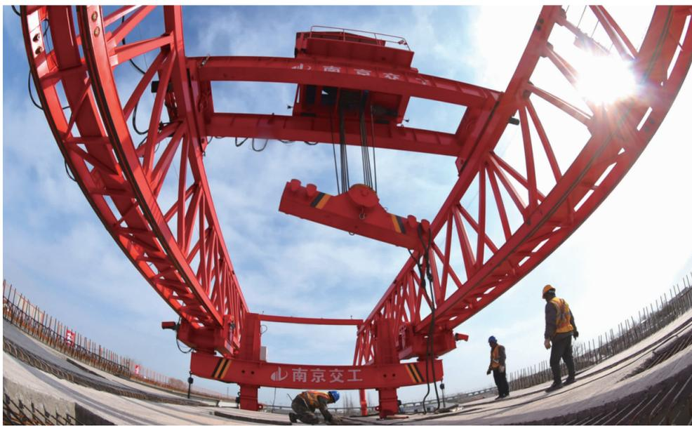
连日来，在连宿高速徐圩至灌云段五标段项目现场，工人正在进行桥梁上部结构作业。200T新式架桥机、钢筋工、模板工各司其职，有序施工，全力以赴抢抓春季施工“黄金期”，加快推进施工进度。 记者 张泽瑞 通讯员 耿玉和 吴林辉 摄影报道
