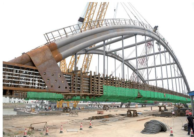
管砼系杆拱整体吊装合拢是该工程的一个重大节点,下一步我们将重点实施拱脚、端横梁、拱肋混凝土浇筑及主桥桥面板施工。”
