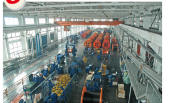
8 全面打响企业改革攻坚战 (2001年) 2001年3月19日,我市召开全市企业改革工作会议,全面打响企业改革攻坚战。至2004年末,全市1317家镇办、市属国有集体企业完成改制,逐步建立“产权清晰,权责明确,政企分开,管理科学”的现代企业制度。2001年,上上电缆完成改制。
