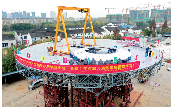
江门中微子实验有机玻璃球安装(升降)平台联合演练
