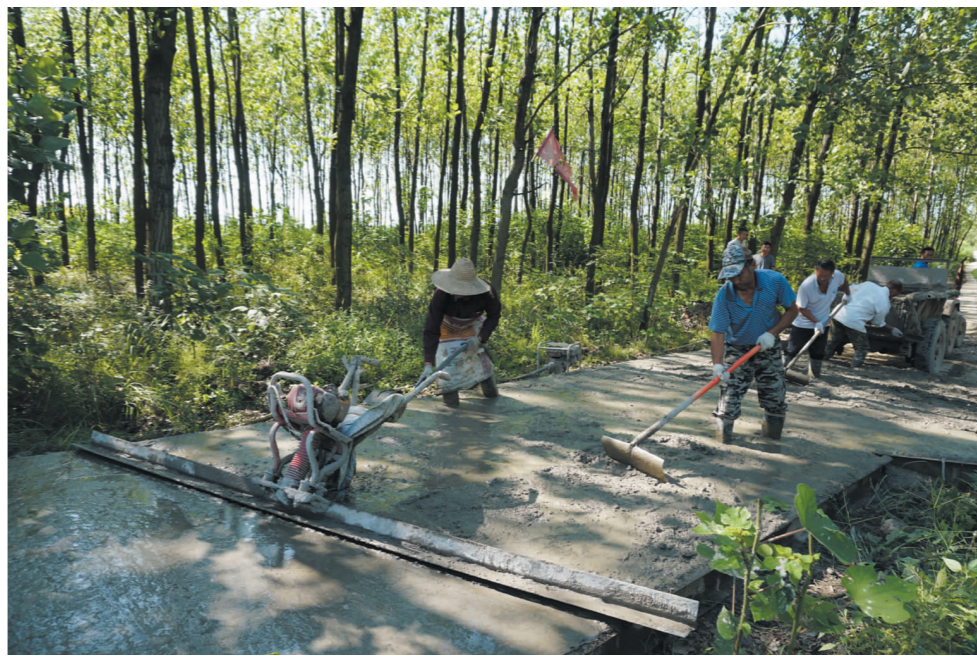
近日，在沙河镇白米村境内，一条路面宽3米，长约1800米的水泥路解决了白米村杨岗组、同建组、吴刚组约1000余居民的出行难问题。加强乡村基础设施建设一直是沙河镇民生实事的重点工程。去年至今，该镇全力实施了6个村道路硬化工程，累计投资380余万元，硬化农村道路10公里，受到村民的一致拥护和好评。 关敬梅 摄
