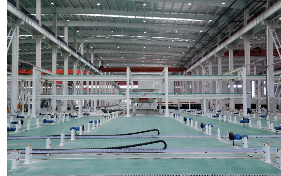
智能制造项目——金鹏国家级装配式建筑智造基地
