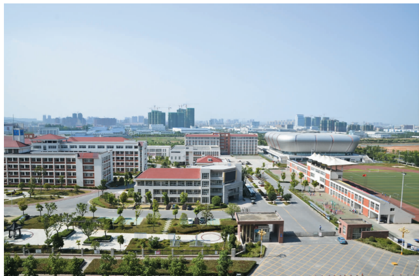
建设项目——滁州中学
