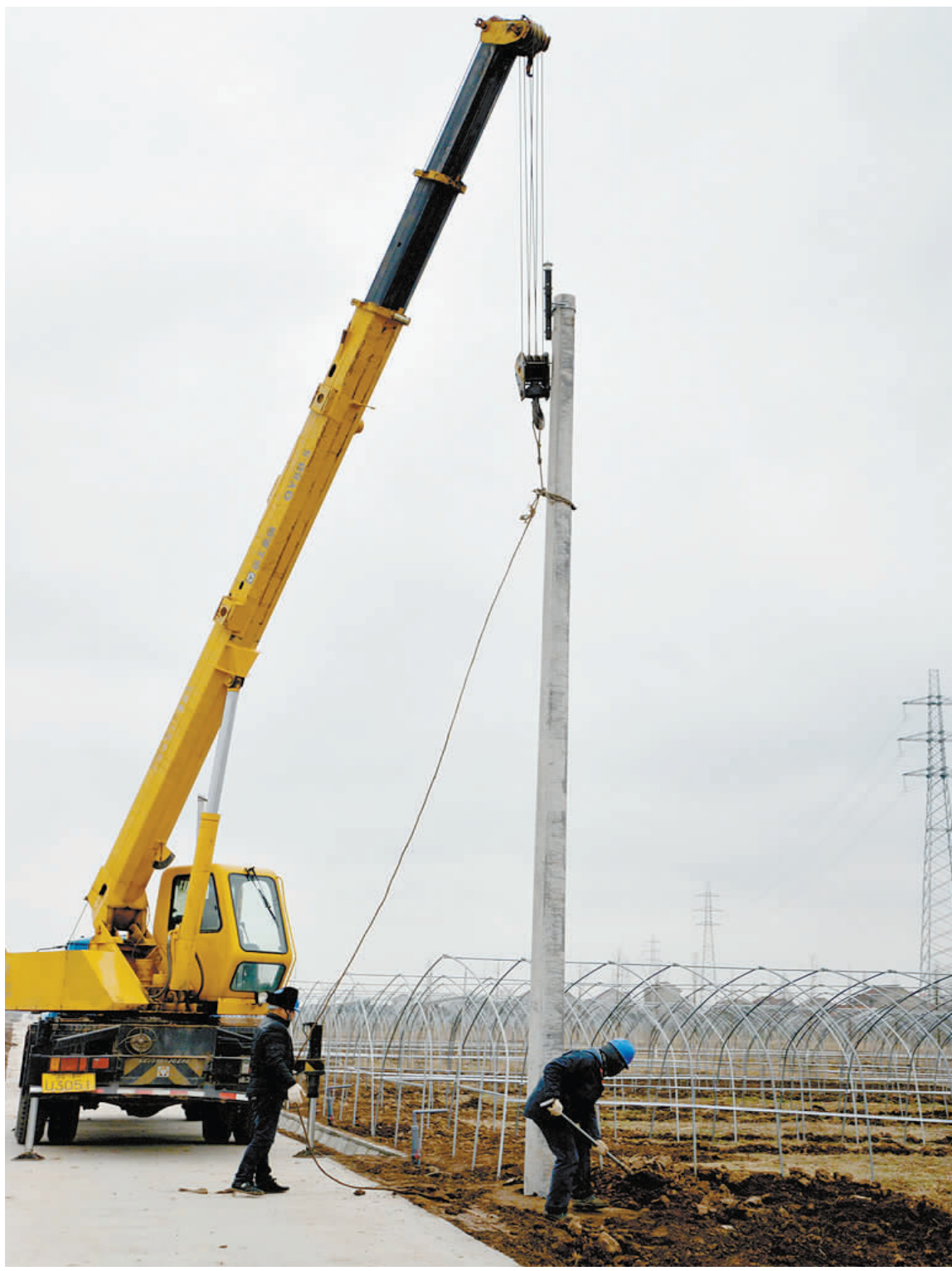
2月12日下午,2013年王鲍镇高标准农田示范工程项目二厂村现场,市供电公司工作人员在加紧架设高压输电线路,确保节水灌溉工程尽快投入使用。据了解,该项目于去年获国家农发办批复,财政总投资1300万元,建设高标准农田面积1万亩。
