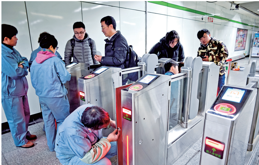
工作人员正在调试新安装的闸机。
