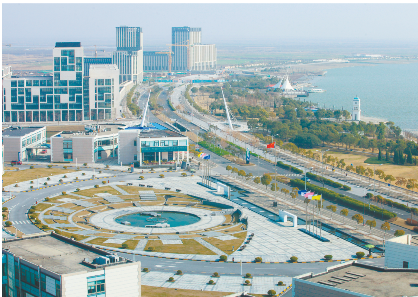
临港地区的发展离不开金融机构的支持,临港企业需要丰富多样的金融服务。 □本报记者 朱泉春/摄
