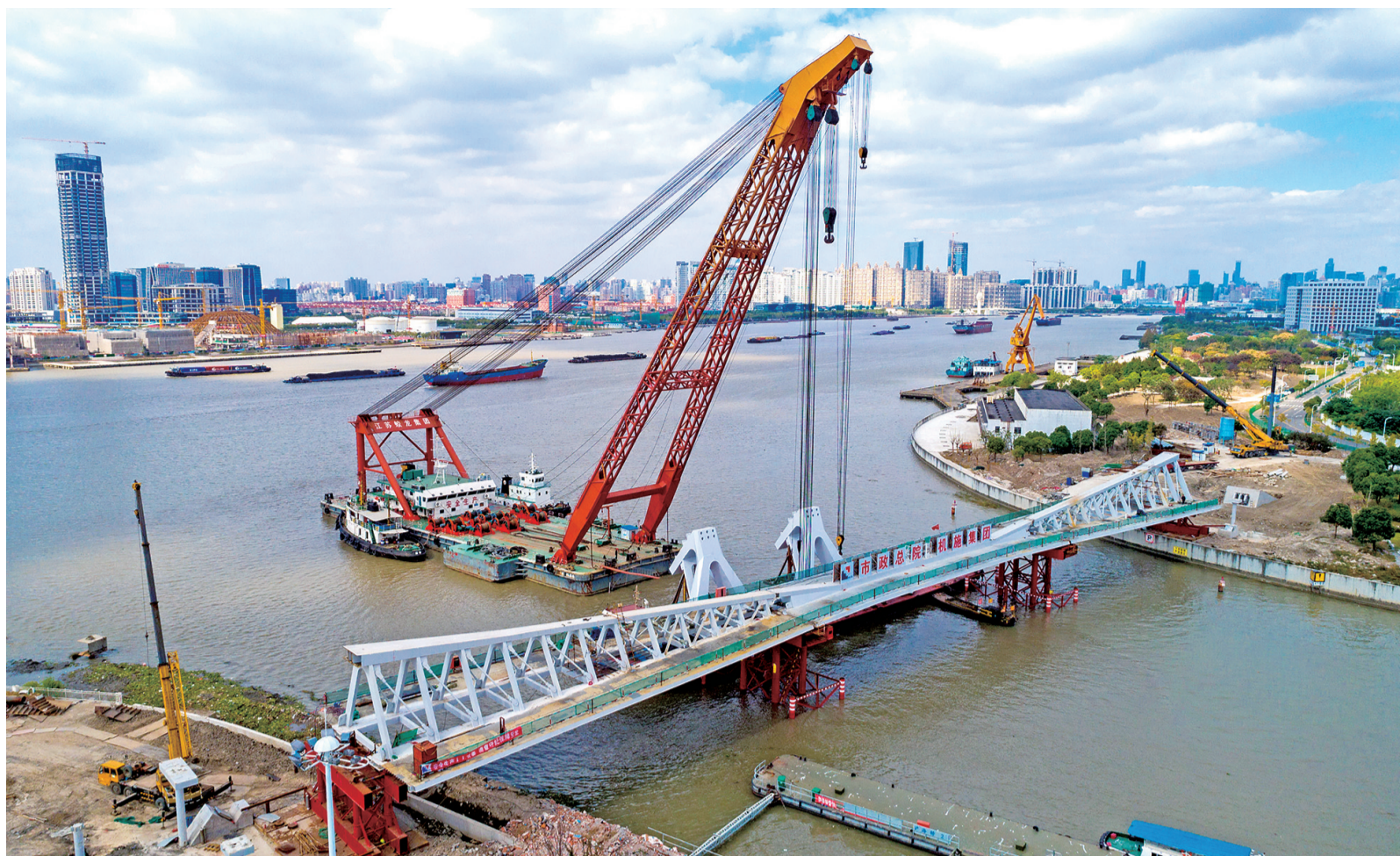
在川杨河汇入黄浦江处,白色的主桥已经跨越河面。 □见习记者 郑峰 摄
