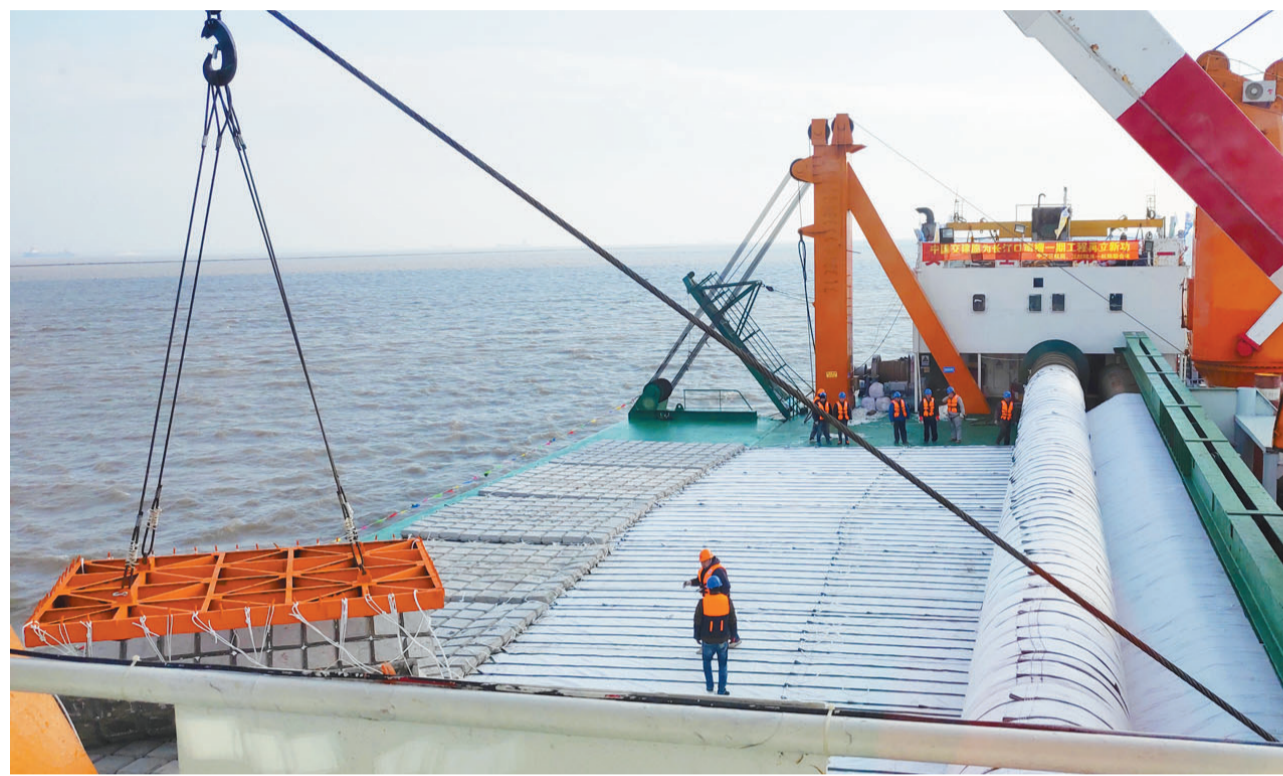
总投资18.77亿元的长江口南槽航道治理一期工程近日开工建设。 □长江口航道管理局 供图
