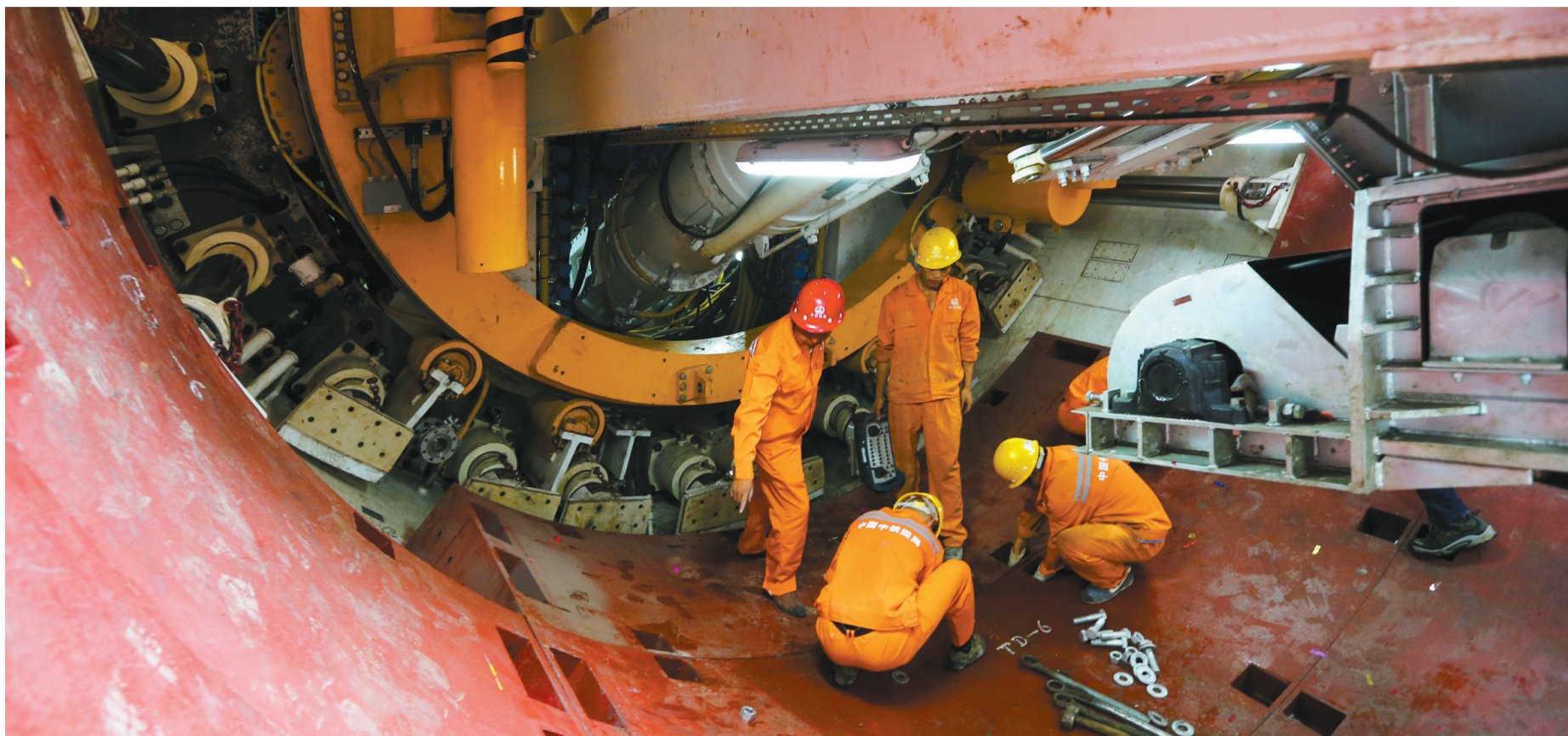
施工人员在现场紧锣密鼓地施工。
