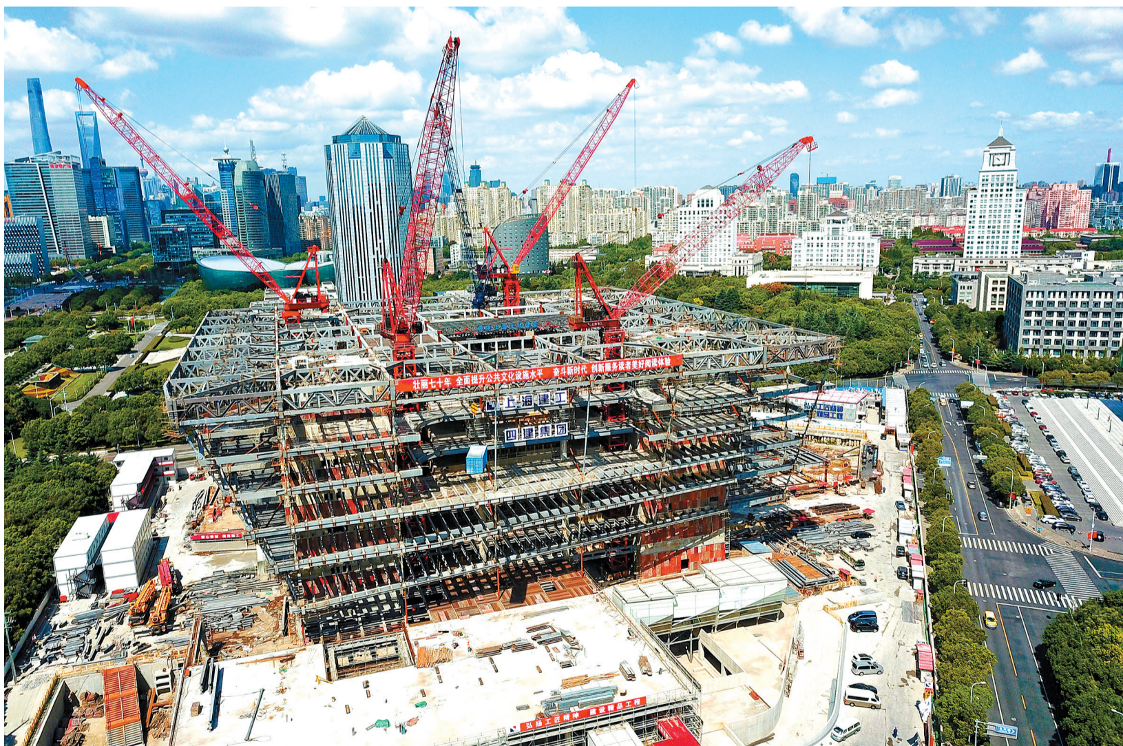
上图东馆封顶后,将开展幕墙、精装修施工,预计于2020年竣工。 □见习记者 黄日阁 摄
