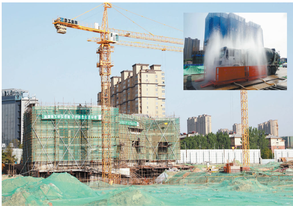
日前,记者走进金融中心、双院池地块等项目建设现场,只见一边是雾炮机等设备喷淋,一边是工人一刻不停忙建设。(摄影 承松 肖畅)
