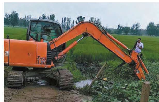
杨屯镇挖沟排水
