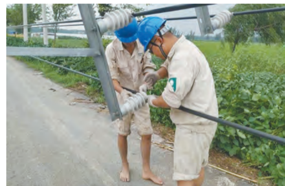
供电部门开展抢修复电作业
