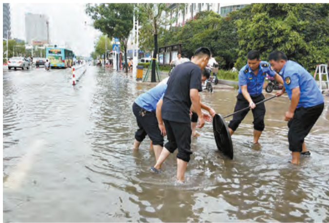
城管队员疏通下水口
