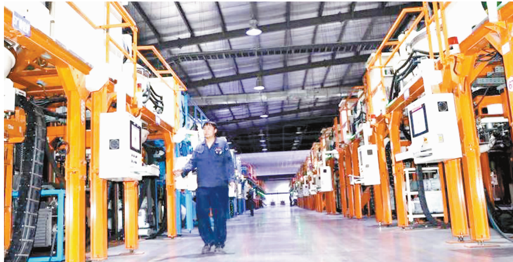
江苏拓正茂源新能源有限公司多晶硅铸锭项目,总投资10亿元,占地110亩,总建筑面积5万平方米。现有128台铸锭炉投入运营,该项目全部建成后,可年产多晶硅1万余吨,年产值可达20亿元,税收可达1亿元。图为该公司铸锭炉车间。
