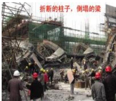
混凝土由北向南单向双管推进时,浇至主次梁交叉点区域时,该区域的每平方米理论钢管支撑杆为6根,由于缺少水平连系杆,实际3根立杆受力,又由于梁底模下木枋呈纵向布置在支架水平杆上,使梁下中间立杆的受力过大,个别立杆受荷最大达到4吨,综合模板支架上部架体步高大的达到2.5米,造成支撑作用不同步和不均衡受载,以及混凝土输送泵管冲击和振动等影响,使其模板支架承载能力超过设计荷载,使节点区域中间单立杆首先失稳,迅即引起高支模支架的整体坍塌。
