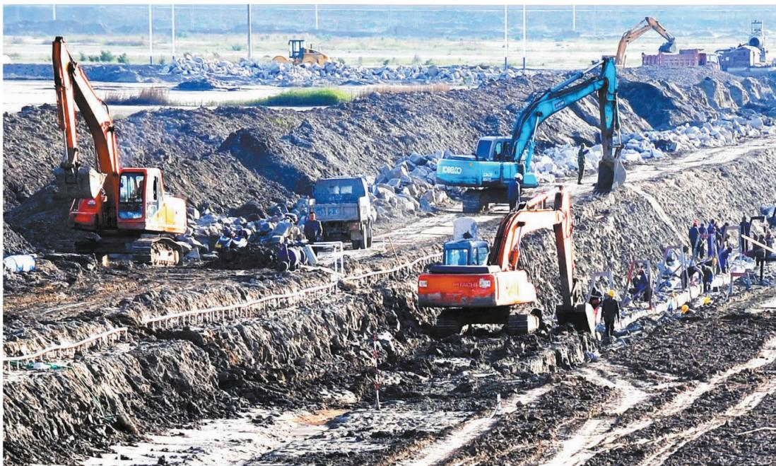
5月7日,吕四港经济开发区石化新材料产业园纬八路新建工程现场,工人正在进行中央河道挡墙施工。该工程总投资2800万元,今年3月正式开工,9月可望竣工。
