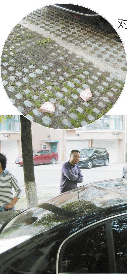
“肇事”的砖块 ▼ 车顶被砸出一个大坑
