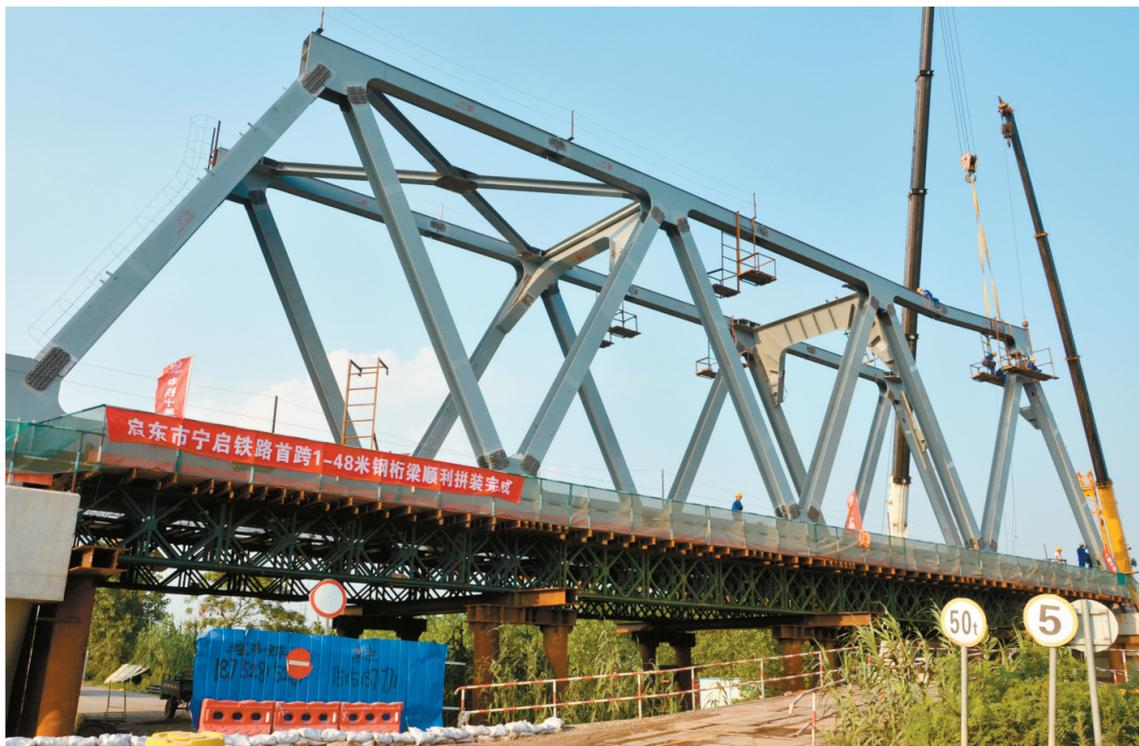
7月23日,宁启铁路启东段首跨1-48米钢桁梁顺利拼装完成。该工程由中铁十局宁启铁路通启段工程项目部二分部负责建造,位于大生镇西南侧,横跨久新公路和久隆河,钢桁梁跨度48米,比原计划提前了22天完成。图为施工现场。 郁卫兵摄
