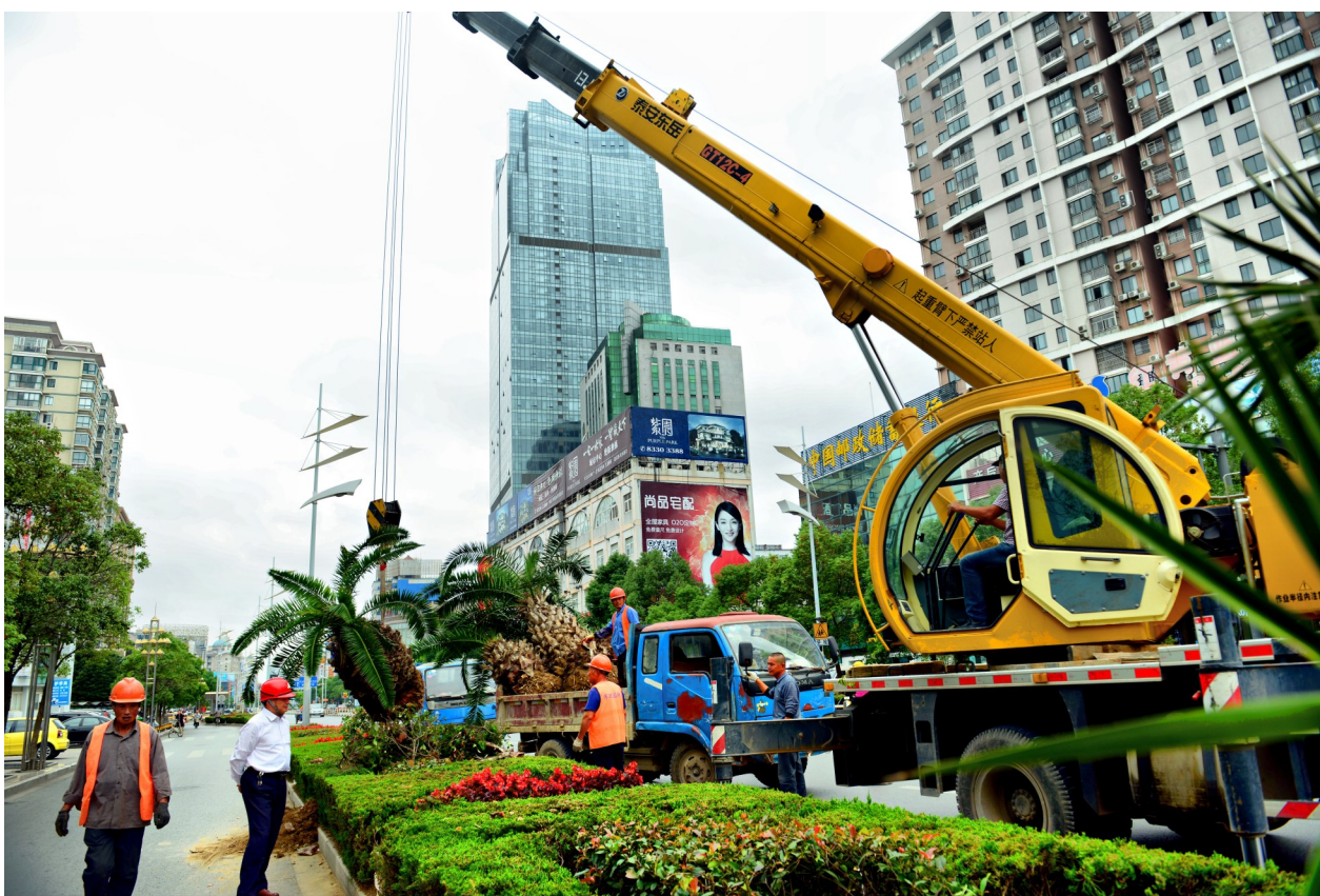
10月18日,市区人民路,市政园林建设有限公司的工人们拆除加拿利海枣景观树。据悉,我市于2002年引进300棵加拿利海枣作为人民路上的景观树。尽管园林部门悉心呵护,但加拿利海枣仍无法适应这里的气候环境,园林部门无奈将其拆除,改种适宜我市气候的广玉兰。姜雨蒙摄
