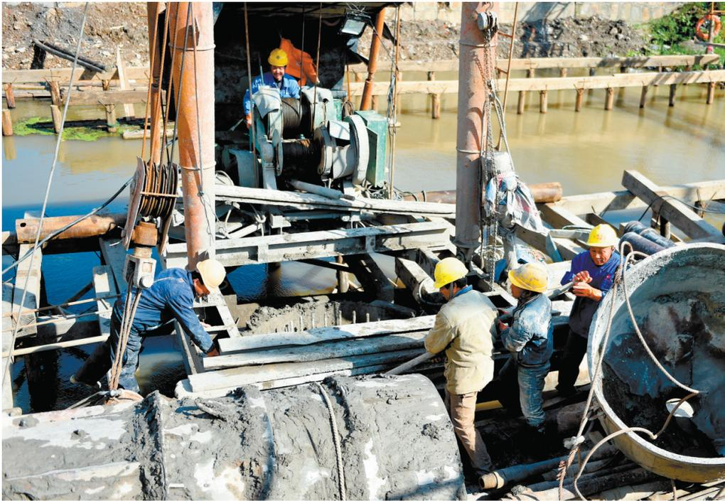
11月1日上午,苏221线南阳村桥危桥改造施工现场,工人在为灌桩做准备。该桥位于苏221线K185+698处,桥宽22米,原上部结构为8+10+8米简支实心板梁,拆除重建后为5.4+16+5.4米的简支板梁,预计明年1月底竣工通车。
