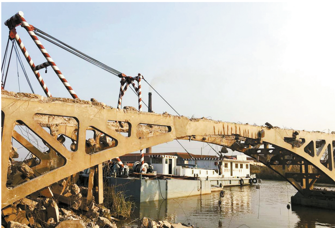
12月7日上午,通启河久隆桥为期三天的旧桥拆除工程开始进行。市地方海事处专门派出4名工作人员以及海巡艇、海巡车在施工现场执行维护任务,通过提高对施工现场上下游的巡航频次、扩大巡航范围、加强巡航力度等措施,引导船舶航行、停泊,全力确保了施工水域的安全畅通。张婷玲 李雅美 姜新春摄
