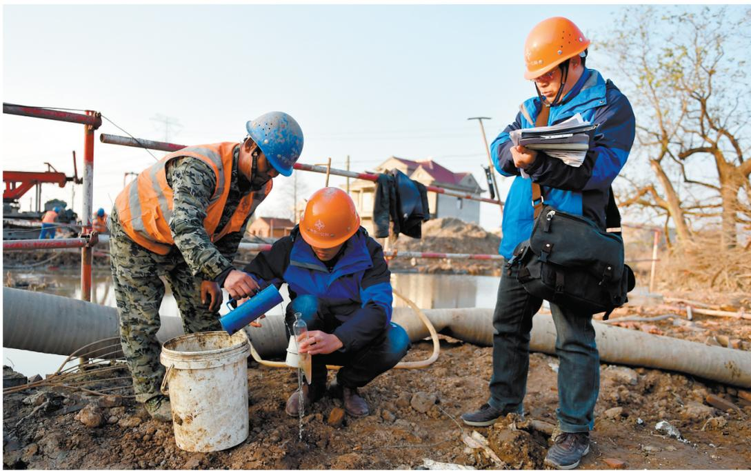
12月21日,海启高速吕四标段施工现场,技术人员在进行桩基泥浆含砂率实验。据了解,海启高速公路全长131公里,其中启东段22公里,北起启海交界吕四港镇巴西村,南与通启高速启东北出口相接,穿越吕四、合作、王鲍、南阳等4个镇。工程于11月正式开工。 潘杨摄
