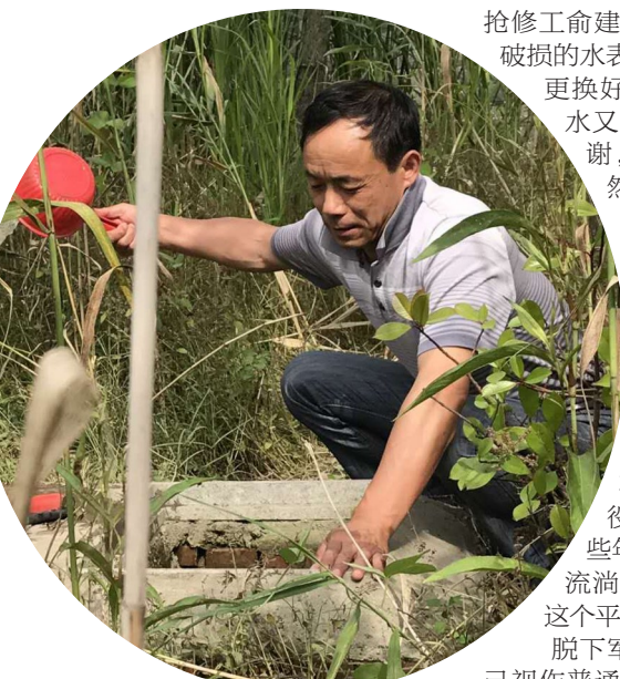
图为俞建飞在紧张抢修
