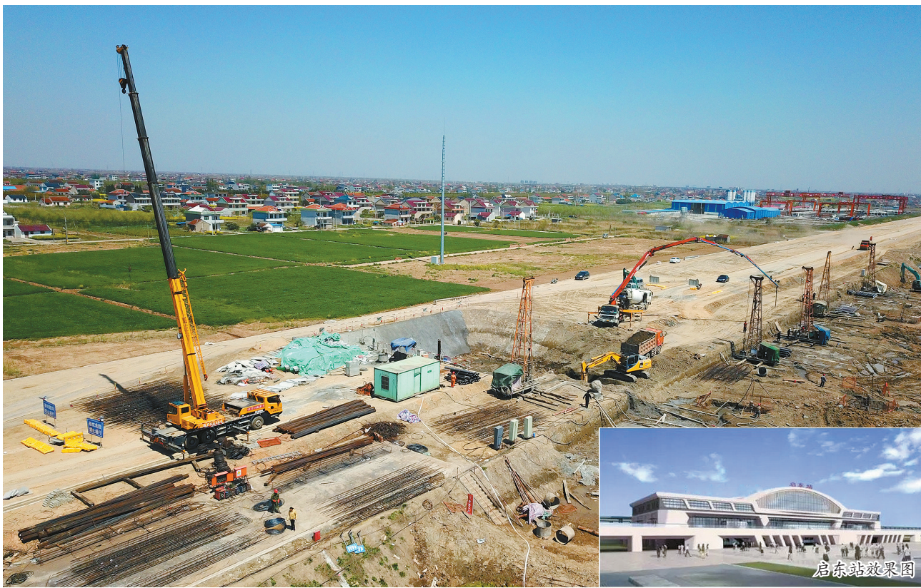
4月8日,启东火车站已正式进入施工阶段,开始站房打桩。 潘杨 郁卫兵 姜新春摄
