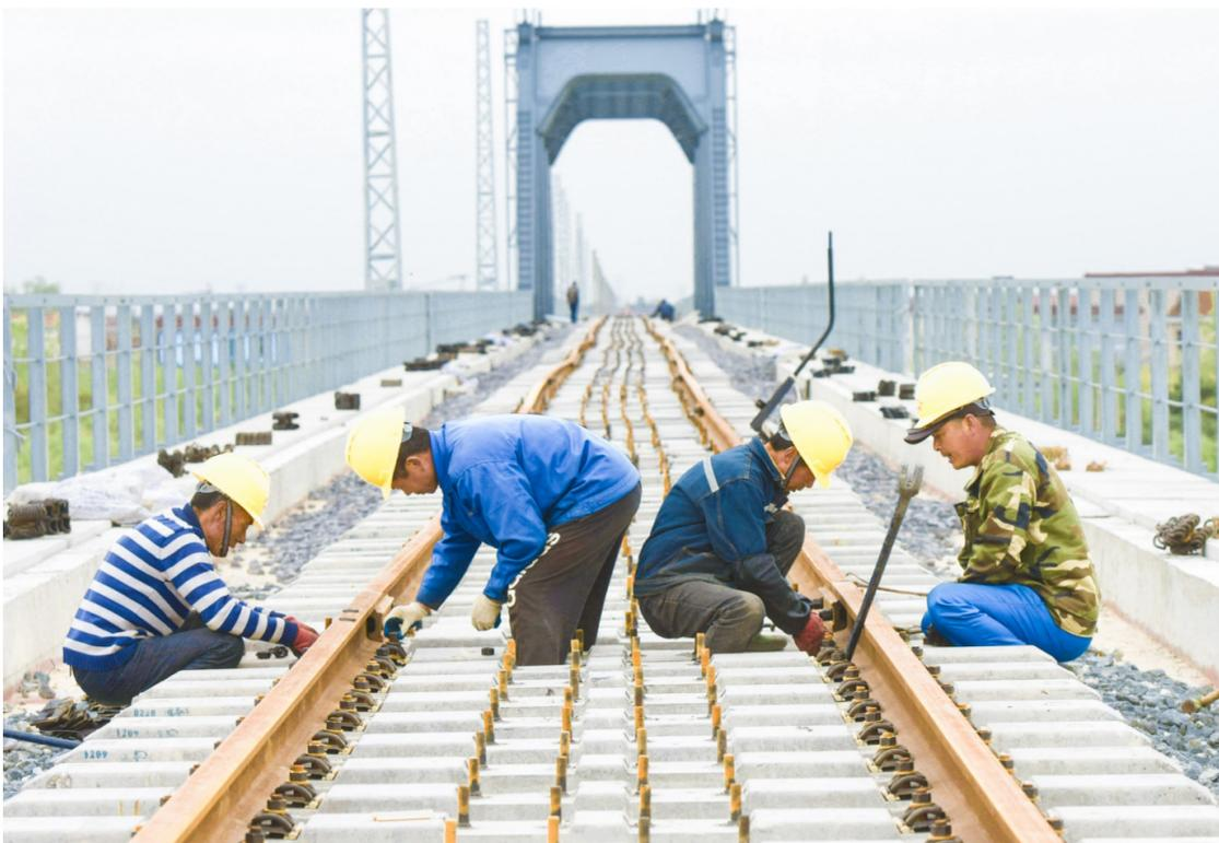
4月16日,在宁启铁路启东段施工现场,工人们正在加紧铺设轨道。
