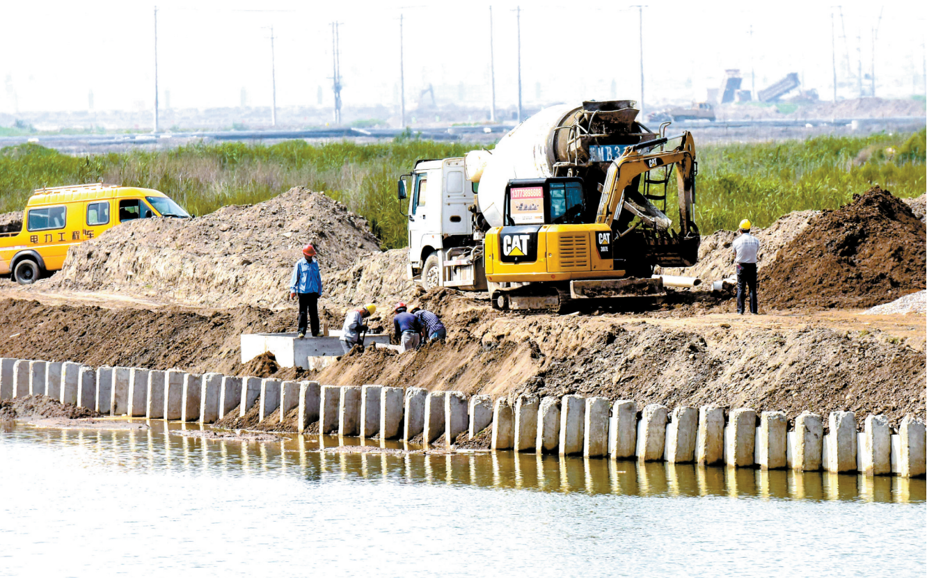
5月14日,圆陀角旅游度假区正在推进3号河道建设。据了解,圆陀角市政道路中央大道北起海港路交叉口,南至环湖大道交叉口北侧,全长50718km,一般路段道路全宽27m,双向四车道,计划于2019年5月竣工。目前3号河道已完成75%的插板桩和约30%的混凝土施工任务。
