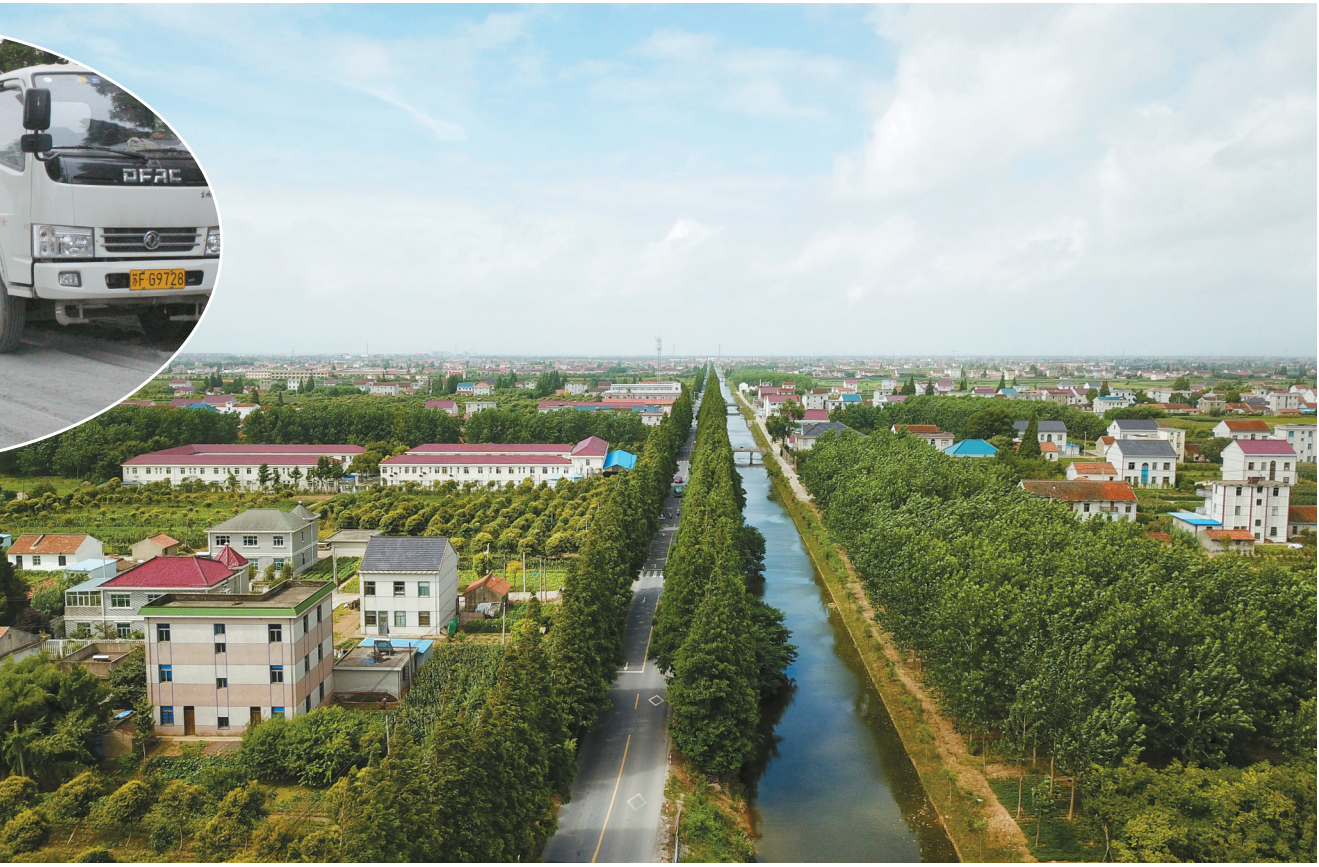
7月9日,施工机械正在对近(海)王(鲍)线南阳镇聚阳集镇西地段实施大修施工(小图)。经过全市交通及公路系统的不懈努力,目前全市440公里县乡道路在全面达到省级路况指标的同时,其养护水平更是连续8年跻身全省先进行列。大图为惠萍镇大兴线路域环境俯瞰。 姜新春 郁剑波摄
