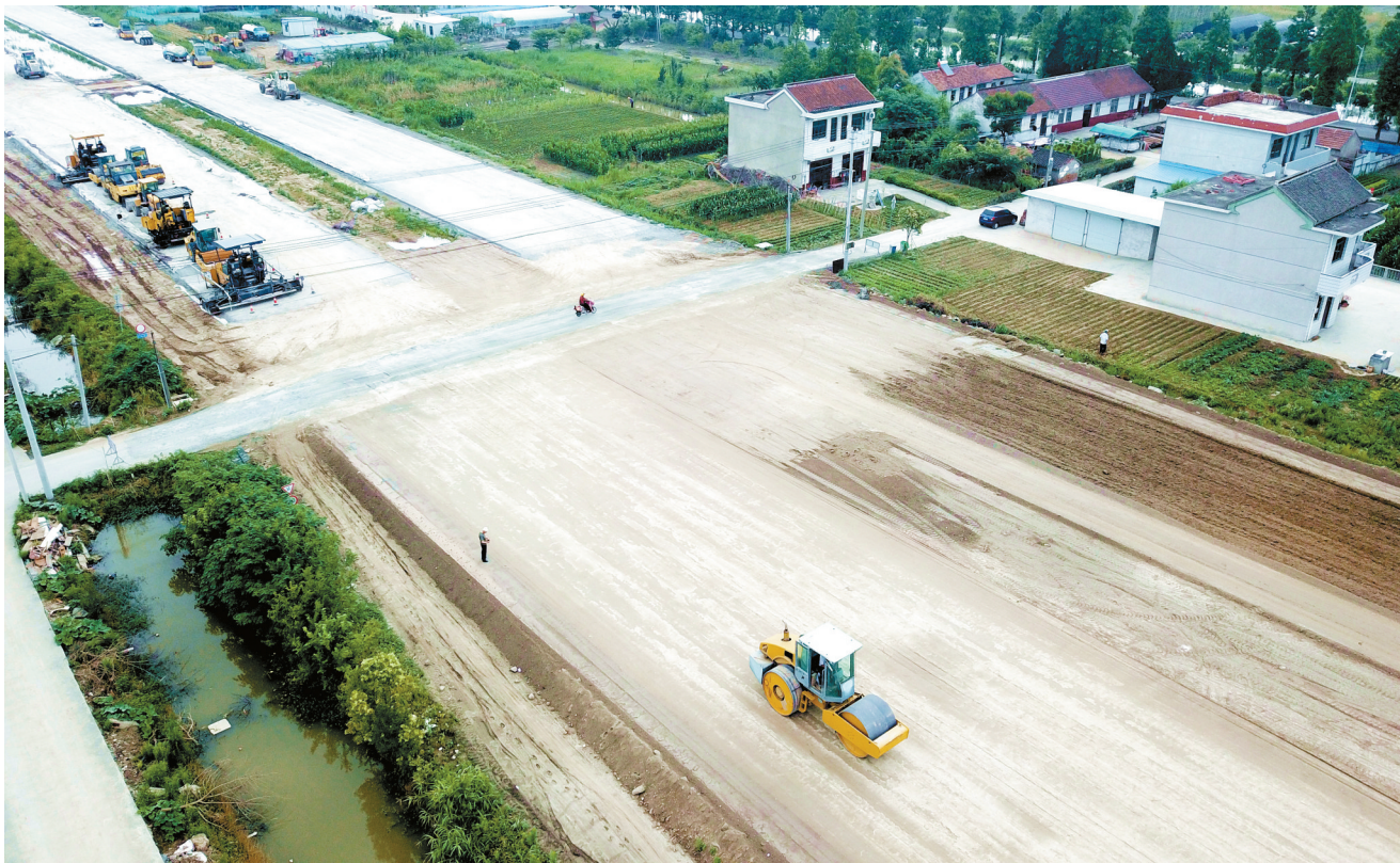
6月23日,丁仓港路北延工程加紧施工。据了解,该路段南起中央大道,北至通海大道,全长6.17公里,于2017年5月开工建设。目前,已完成50%的路面水稳铺设,预计9月份竣工。 郁卫兵 倪熹摄
