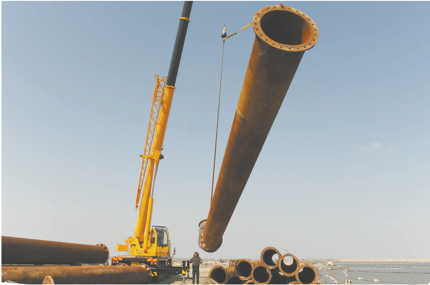
3月5日, 吕四港环抱式港池航道疏浚工程施工现场, 工人吊运吹沙管道。据了解, 航道疏浚工程是今年港池建设的主要任务之一。 潘杨 郁卫兵摄
