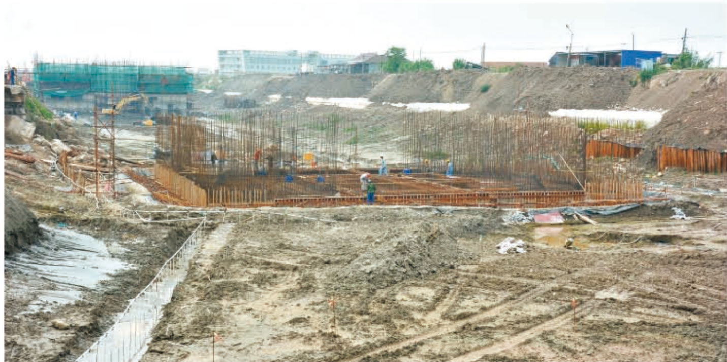
8月16日,连兴港套闸工程正在加紧建设。该工程总投资4000多万元,今年1月开工,预计年底主体工程竣工。截至目前,下游闸已完成工程量的70%,上游闸完成10%。该套闸与老闸相比,排涝能力提高40%,兼通航,方便周边渔民作业。郁卫兵 姜新春摄
