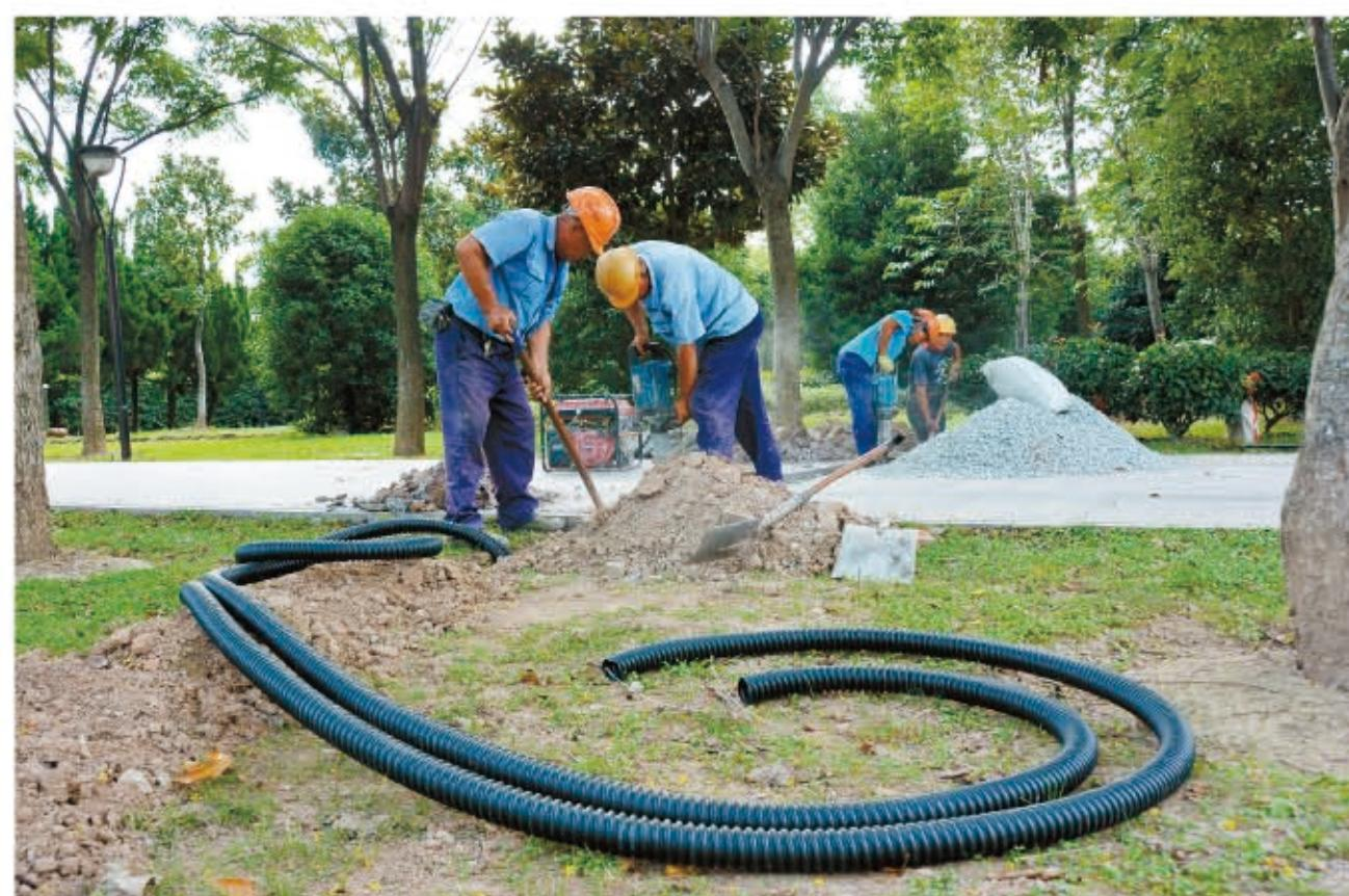
9月11日,电信公司施工人员在紫薇公园挖土铺设wifi线路。
