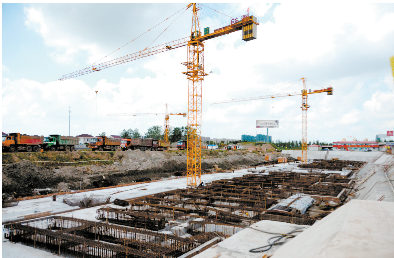
9月16日上午,位于惠萍镇的安置房施工现场,工人们正在进行基础施工。该安置小区建筑面积12万平方米,总投资3亿元。2015年3月开始施工,预计2017年6月竣工。届时,可以安置拆迁群众800户。王婷婷摄
