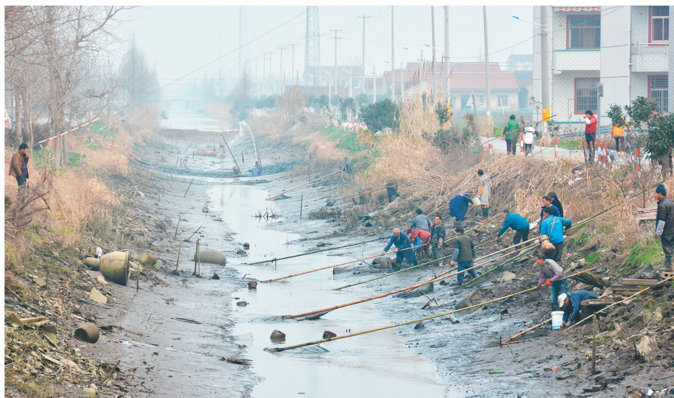
日前,惠萍镇鸿西村村民在打捞淤沟杂物。据悉,该村本月初开始进行水环境整治,经过一个多星期的清理,6条横河面貌焕然一新。(姜新春摄)
