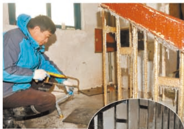
金水苑小区5号楼水管冻裂楼梯已成“冰川”,抢修人员全力抢修中。 郁卫兵摄
