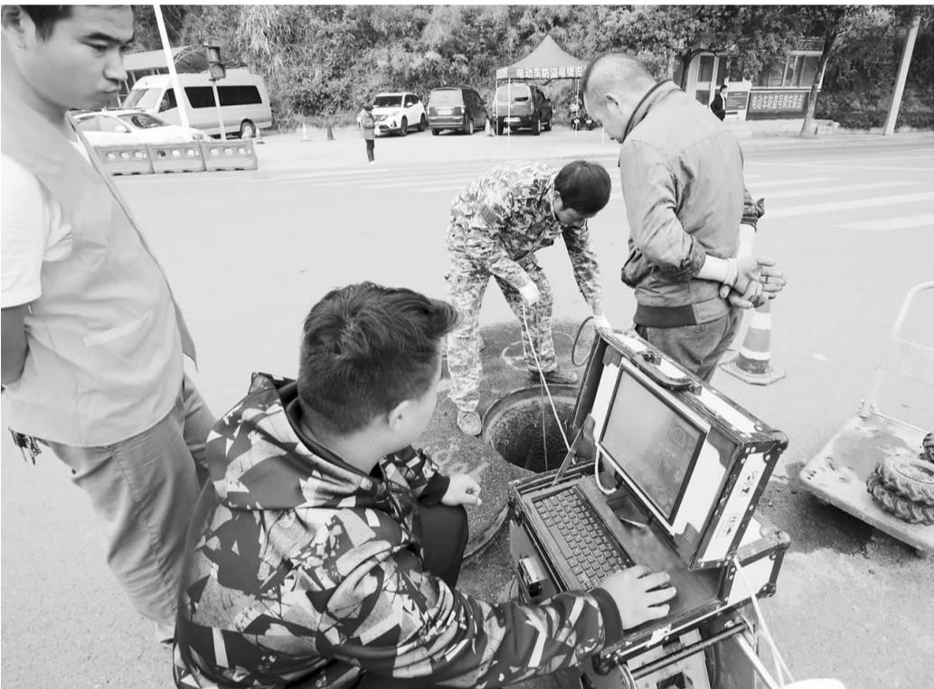
为保证城区排水系统安全稳定运行,近日,市政园林管理处委托管道工程技术人员对县城内主要街道的下水管道进行养护,包括雨污水管道及明暗渠道疏通、检测、修复等。
