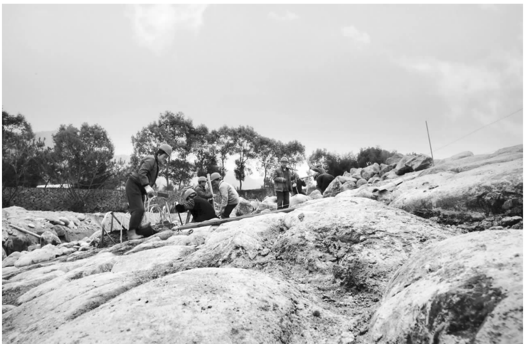
2017年,我县的冬修水利工程主要包括山塘综合整治、小型农田水利、高效节水灌溉等工程,截至目前已投入冬修水利资金6700余万元,已开工或完成各类大小水利工程150余处。图为云峰街道古亭村水利工程现场。 记者 章建辉 摄
