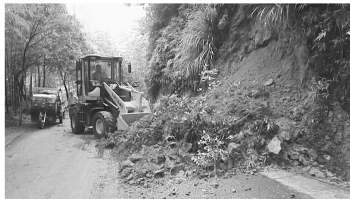
连日来,受降雨影响,我县多处公路沿线山体出现塌方。为保障公路畅通安全,县公路局养护公司第一时间组织人员赶赴现场,利用铲车、运输车等机械设备清理公路山体塌方。
