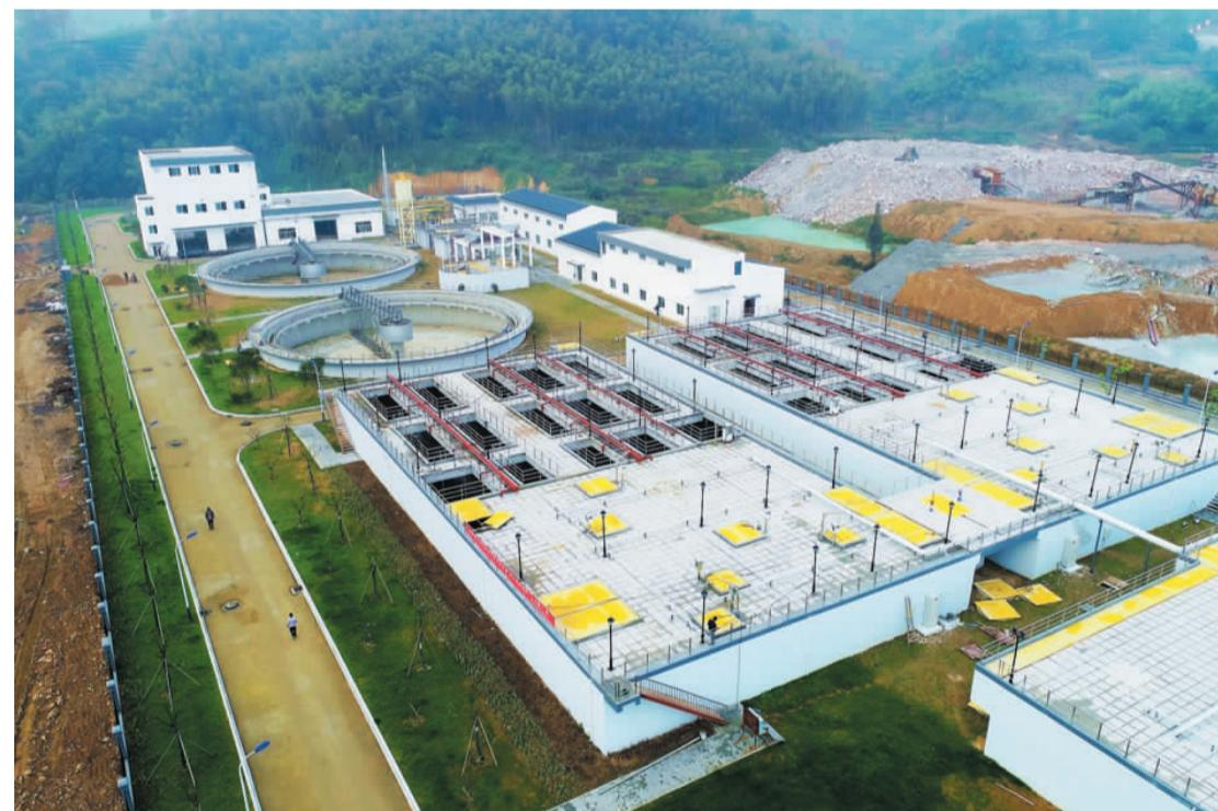
目前,县第二污水处理厂已完成总工程量的91%。该工程位于云峰街道的洋浩区块,建成近期处理能力每天2万吨,远期处理能力每天3万吨的污水处理能力,并形成云峰镇区、龙板山区块、洋浩区块污水接入管网,建成后将极大地改善周围水体环境,对治理水污染,保护当地流域水质和生态平衡具有十分重要的作用。
