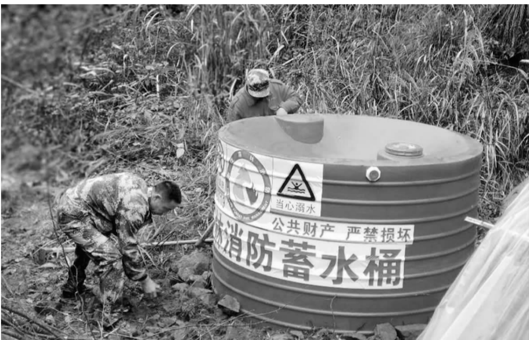
近日,九龙山管理局与县森林消防办在保护区内科学布设森林消防蓄水桶,旨在进一步增强九龙山保护区森林防火基础设施建设。据悉,此次共在3个保护站安装了4个森林消防蓄水桶,每个水桶可蓄水3个立方米。投入使用后,周边区域一旦发生森林火灾,蓄水桶就能为森林消防水车以及便携式水泵提供水源保证。 记者 傅长琪 通讯员 杨晓君 摄
