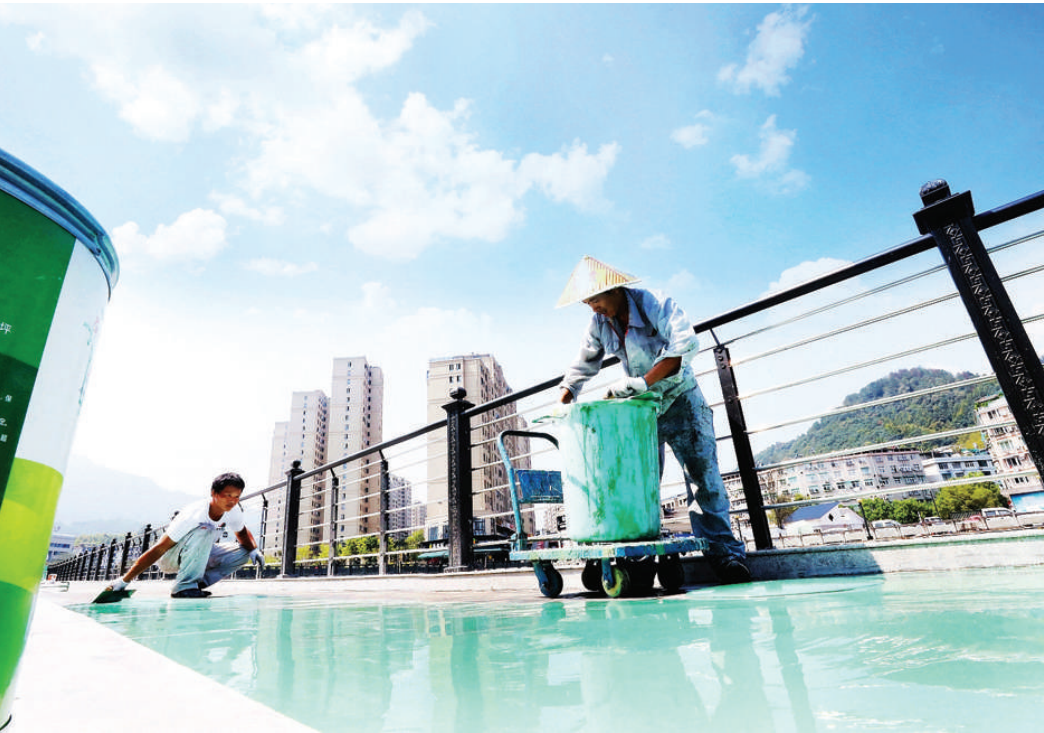
目前,县城南门外路改造工程聚聚自结纹跑道开始施工,预计在本月底前竣工。南门外路改造工程全长约500米,改造后车行道加宽至9米,人行道宽度为3.5米至6.5米,人行道采用花岗岩铺装,聚聚自结纹跑道宽两米,与荷花滩绿道衔接。
