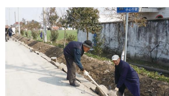
连日来,栟茶镇三星村正抓紧组织人员对9组的硬质渠覆土、重建,确保在庄稼灌溉前竣工。该项目属于县小农水项目,总投资150万元,总长度1500米。近年来,该村加大基础设施建设力度,村里所有桩线道路全部修成水泥路,80%的农渠实现硬化,极大改善了村民生产生活环境。
